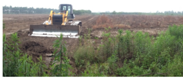
海盐经济开发区建设占用耕地表土剥离工程
