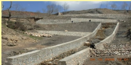
照片5—1—5 矿区斜坡排水渠
