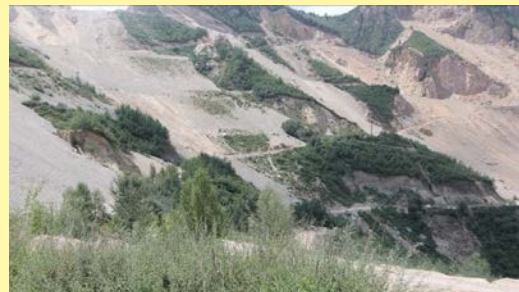
照片5—1—3 坡面整形工程
