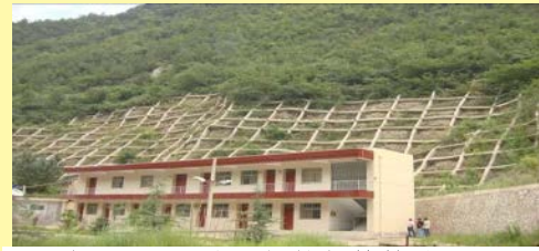
照片5—1—7 小厂坝锚杆格构治理工程
