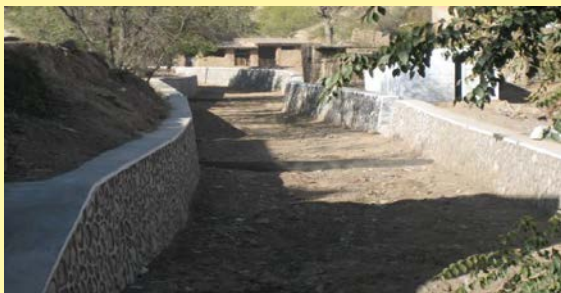
照片5—1—2 治理后沟道景观
