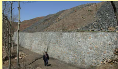
照片5—1—4 挡土墙工程
