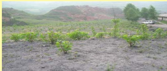
照片5—1—6 坡面绿化工程
