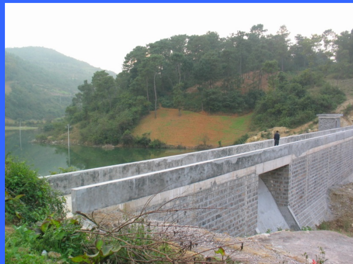
罗平小平桥暗河调蓄水库
