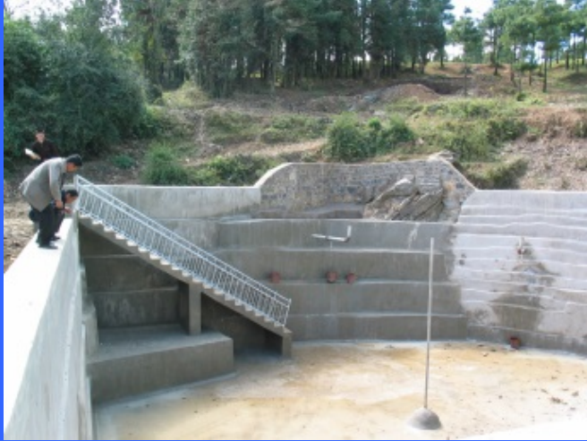
李子箐表层蓄水工程
