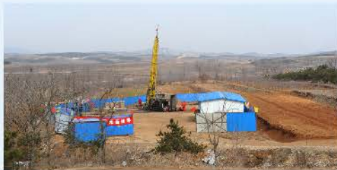
山东金青顶矿区，施工2000米的地质岩心 钻探孔试验示范工程现场
