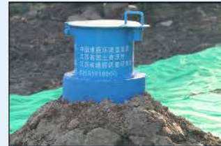
国家地下水监测工程第一眼监测井井口保护装置
