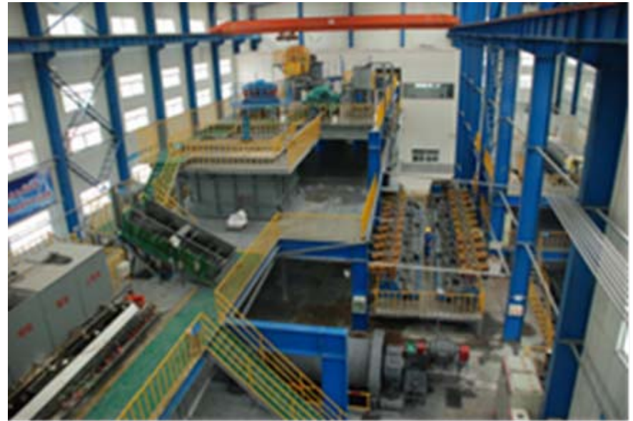
850t/d示范工程现场
