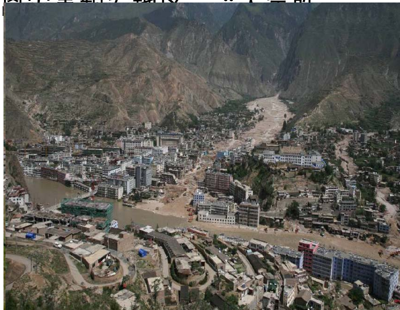
舟曲县城山洪泥石流前后
