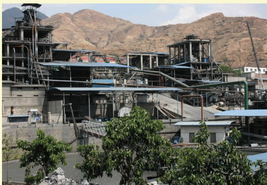
图 6-4 四川龙蟒集团钒钛磁铁矿年处理 150 万吨原矿选矿厂
