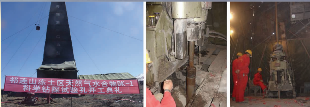
图 4-15 天然气水合物钻探施工现场
