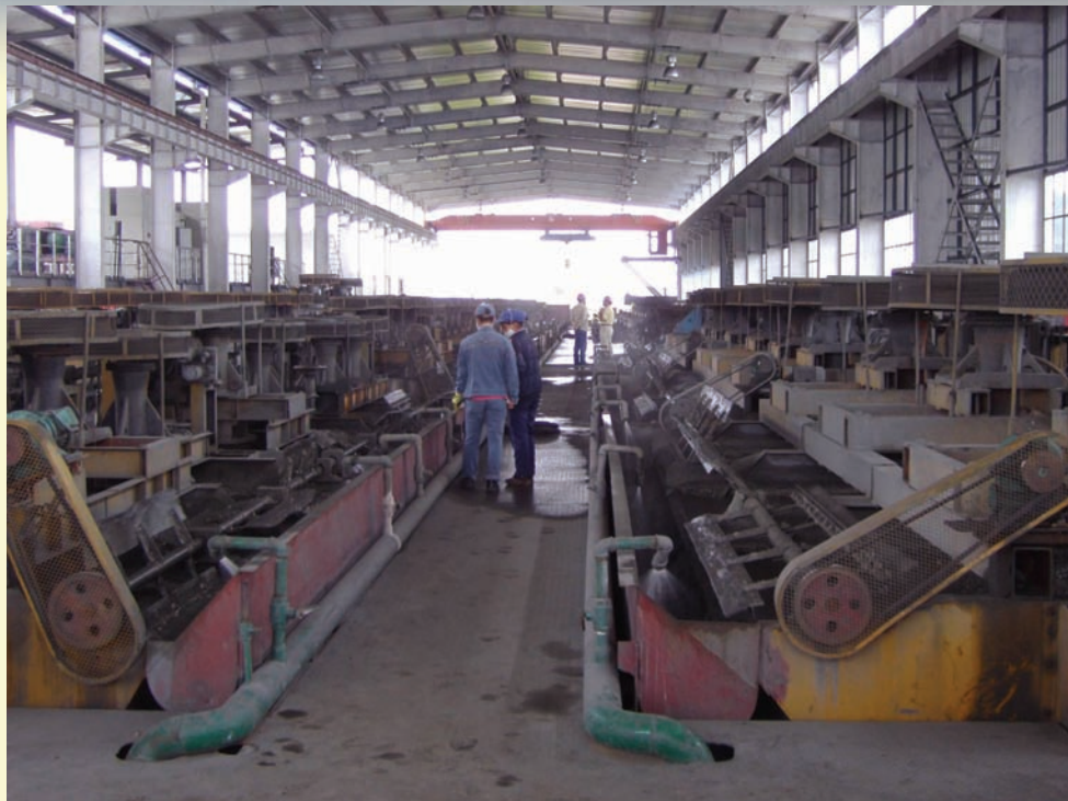
图 6-6 中凯矿业公司铜钼铅锌共生矿综合利用选矿厂
