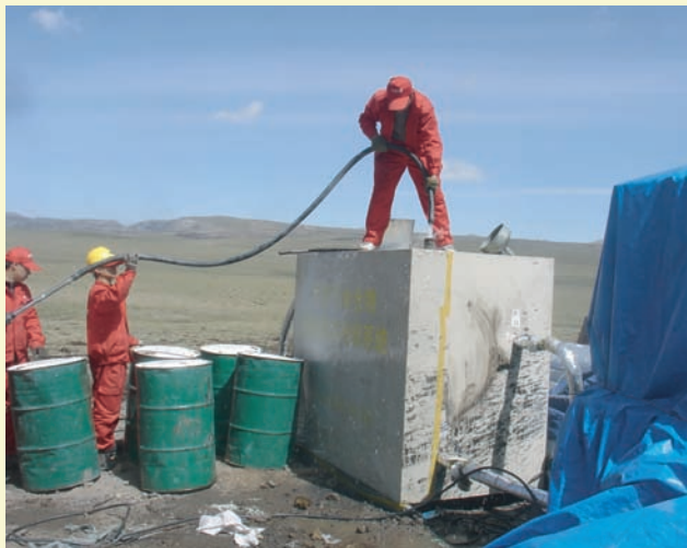
图 2-55 水合物钻井泥浆冷却系统 (添注乙二醇制冷液)
