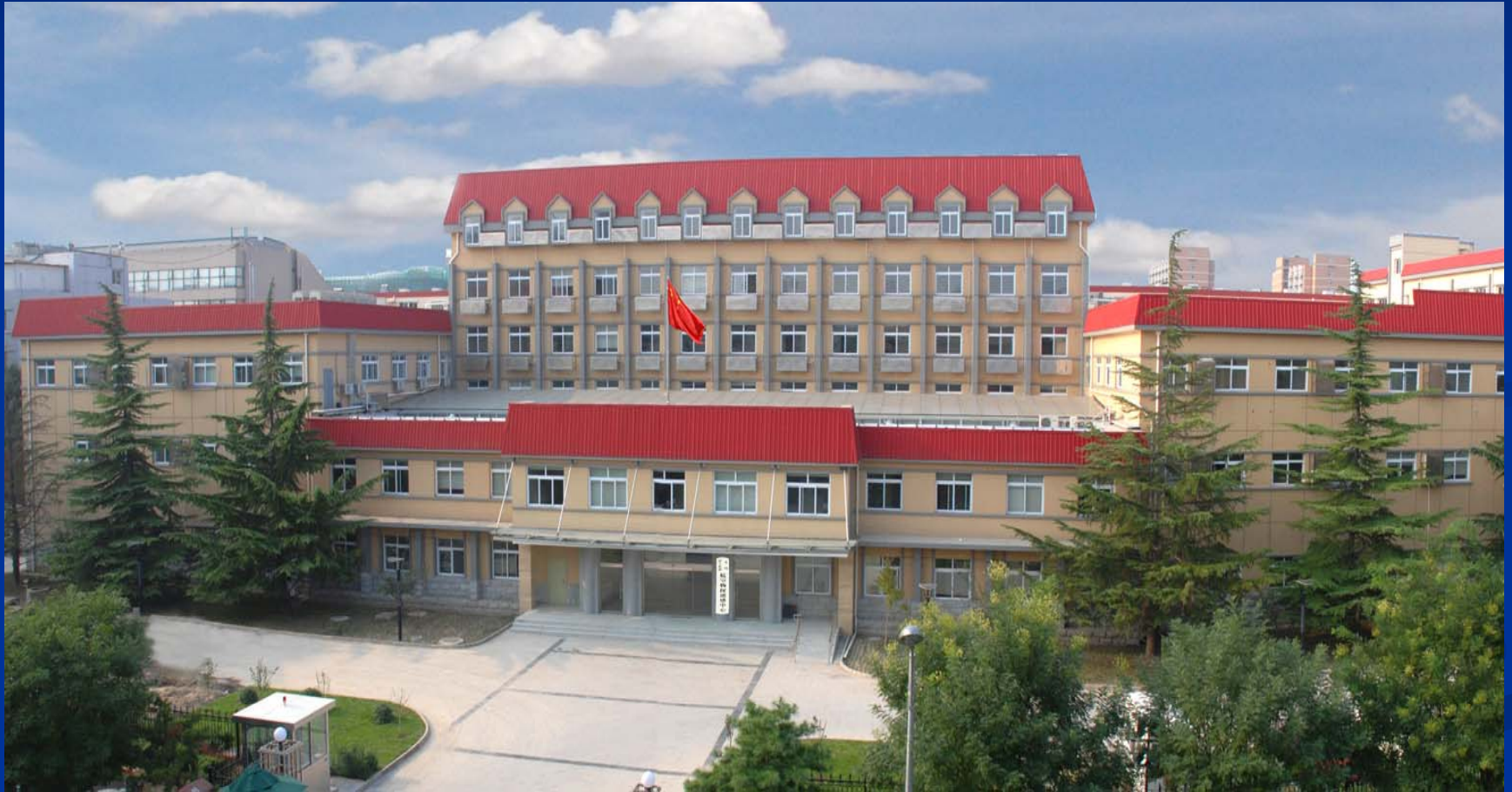
航遥中心办公楼
