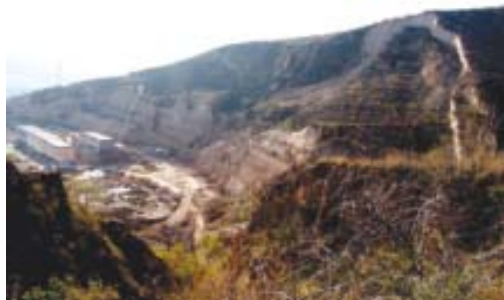
由于在滑坡前缘开挖坡脚，后缘出现弧形下错裂缝，滑坡即将发生（陕西延安杨崖，2006）
