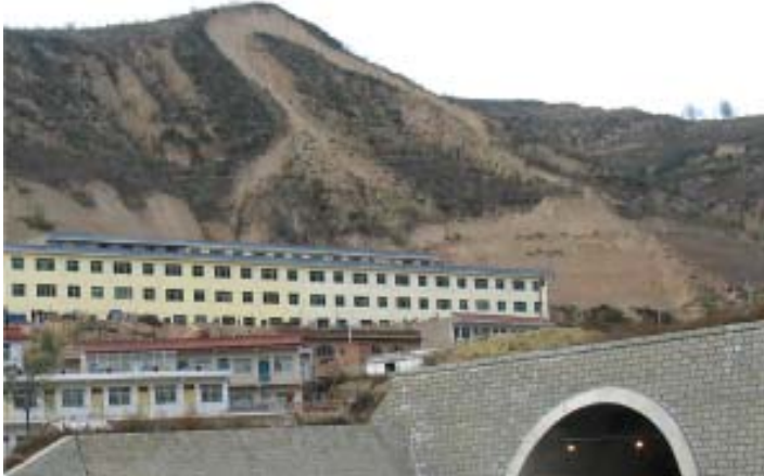
后缘出现明显的弧形下错裂缝,显示滑坡将整体滑动 (陕西延安,2006)
