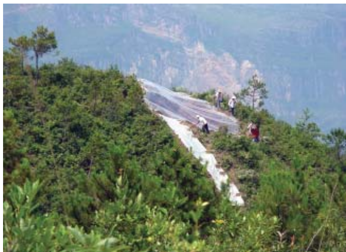
利用塑料布铺盖危岩体裂缝和落水洞，避免雨水直接灌入 (重庆巫山，2000)
