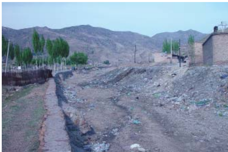
随意倾倒弃土垃圾于冲沟中，挤占行洪通道，形成新的泥石流物源（河北张家口，2004）
