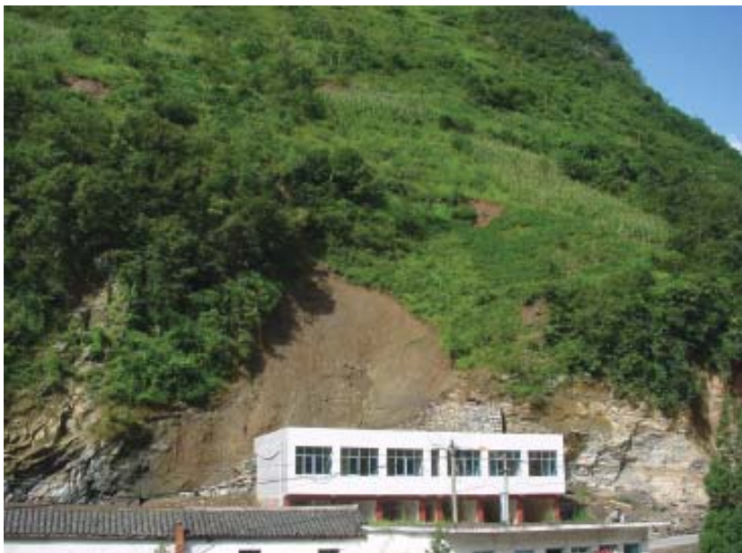
兴建房屋时，后山切坡和不合理支护留下滑坡隐患（陕西平利，2000）
