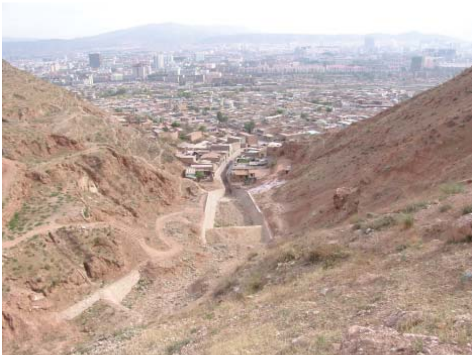
泥石流沟流通区被人为改道和缩小断面，埋下灾害隐患（青海西宁北山林家崖，2006）
