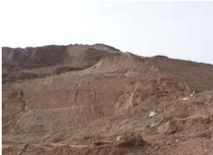
前缘出现有规则的纵张裂缝，显示滑坡非常危险（陕西延安，2006）
