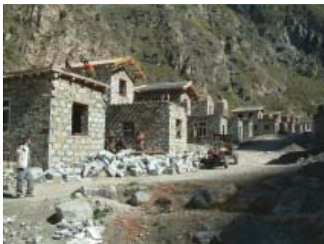
因地质灾害搬迁避让的新村正在建设中 (四川康定, 2005)
