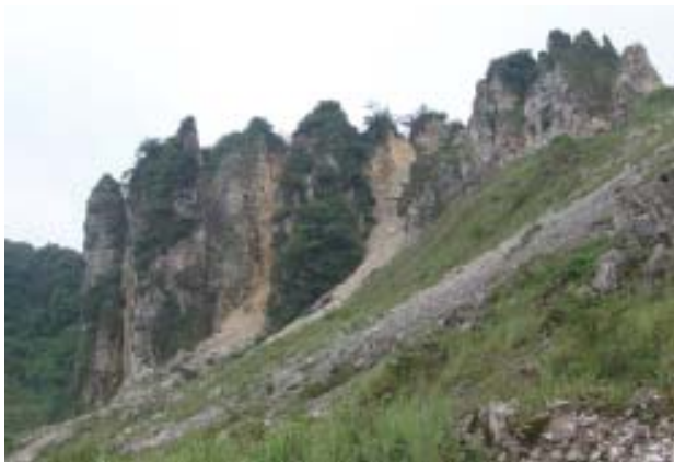
岩体被多组裂缝切割，稳定性差，极易发生崩塌（贵州开阳，2006）
