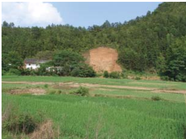
丘陵山区切坡建房,边坡土体风化强烈,稳定性差,极易发生滑坡 (江西瑞金, 2005)
