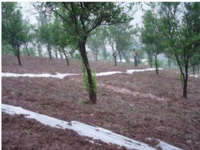
利用塑料布铺盖滑坡后缘拉裂缝，防止雨水直接渗入 (重庆云阳，2000)
