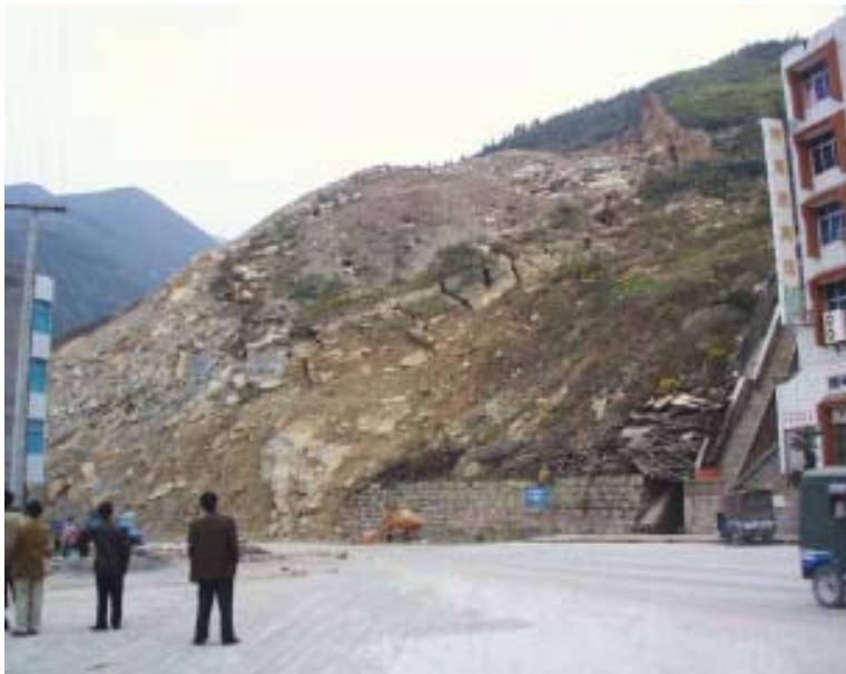
斜坡因切脚和爆破引发顺层滑坡（湖北巴东白崖沟，1999）
