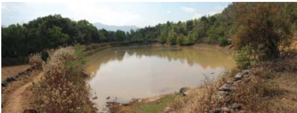
滑坡后缘洼地水塘未经防渗处理，池水易于渗入滑坡中，加剧变形（云南新平，2005）
