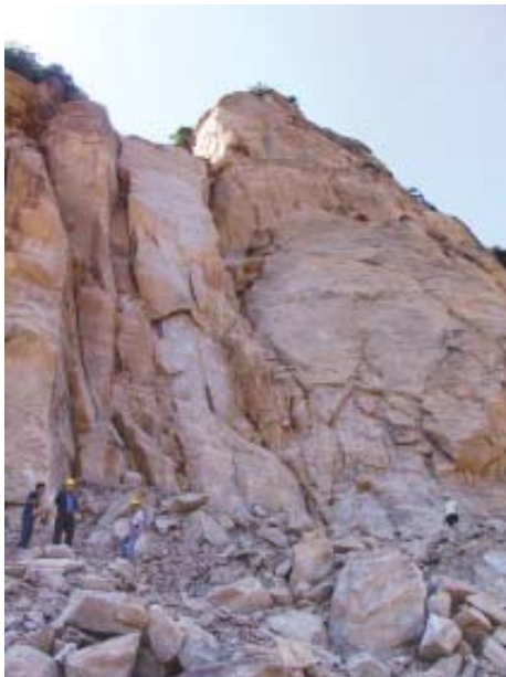
北京密云黑龙潭崩塌，堵塞道路（2005）
