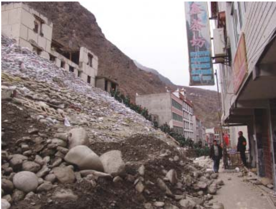
在前缘紧急放置沙袋压脚，有效减缓了滑坡变形滑移（四川丹巴，2005）
