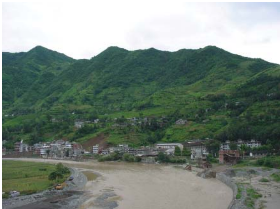
建设密度过大,开挖滑坡体前缘导致局部滑动(陕西岚皋,2000)
