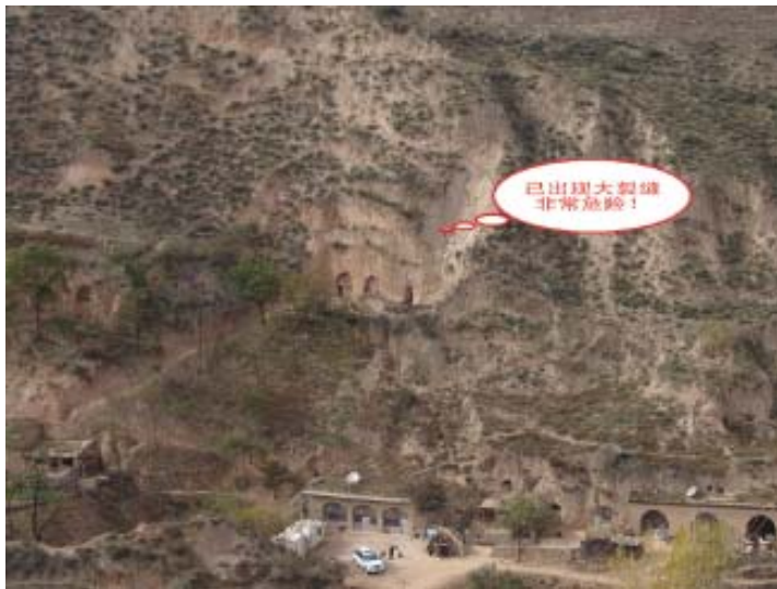
窑洞后山出现大裂缝，要加大监测，并尽快采取应急措施 (陕西延安，2006)
