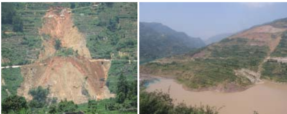
滑坡毁坏道路和房屋(福建建瓯, 2006) 湖北秭归干将坪滑坡滑动堵江, 21人死亡(2003)
