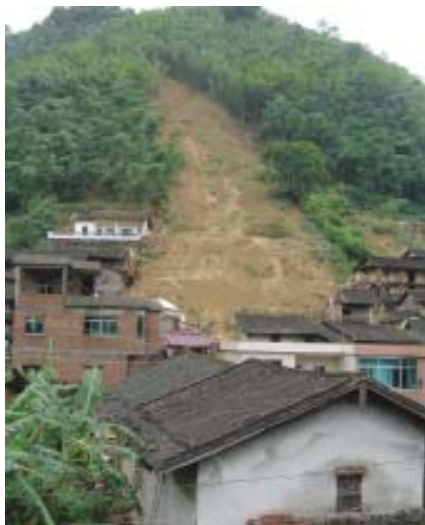
植被茂密区也必须严防滑坡泥石流灾害 (福建安溪，2005)
