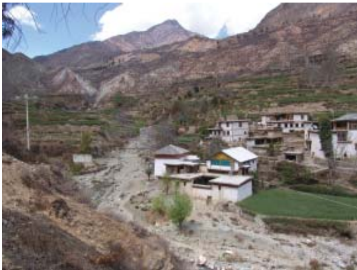
民居建于泥石流沟边，特别是上游滑坡堵沟溃决时，非常危险 (云南中甸，2006)
