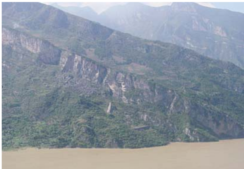
长江三峡库区链子崖危岩体 T0~T7 缝区危岩崩塌（2004）
