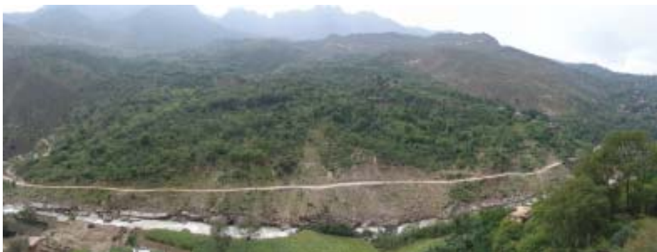
甲居藏寨滑坡前缘被江水冲刷掏蚀，局部滑塌，但整体稳定性好（四川丹巴，2006）
