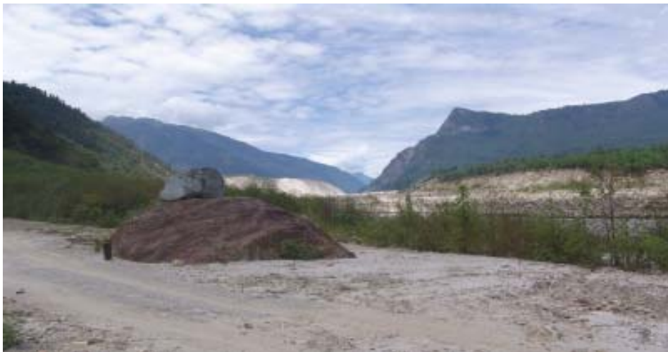
2000年发生的西藏易贡滑坡体积达3亿立方米，是我国近年来发生的最大滑坡。堵江成湖，溃坝后形成泥石流，流量达12万立方米/秒。携带的巨石叠置。远处为滑坡坝溃决后的残体（2006）
