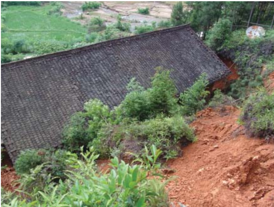
开挖边坡建房未加合理支护，雨季发生滑坡，毁坏房屋（江西瑞金，2005）
