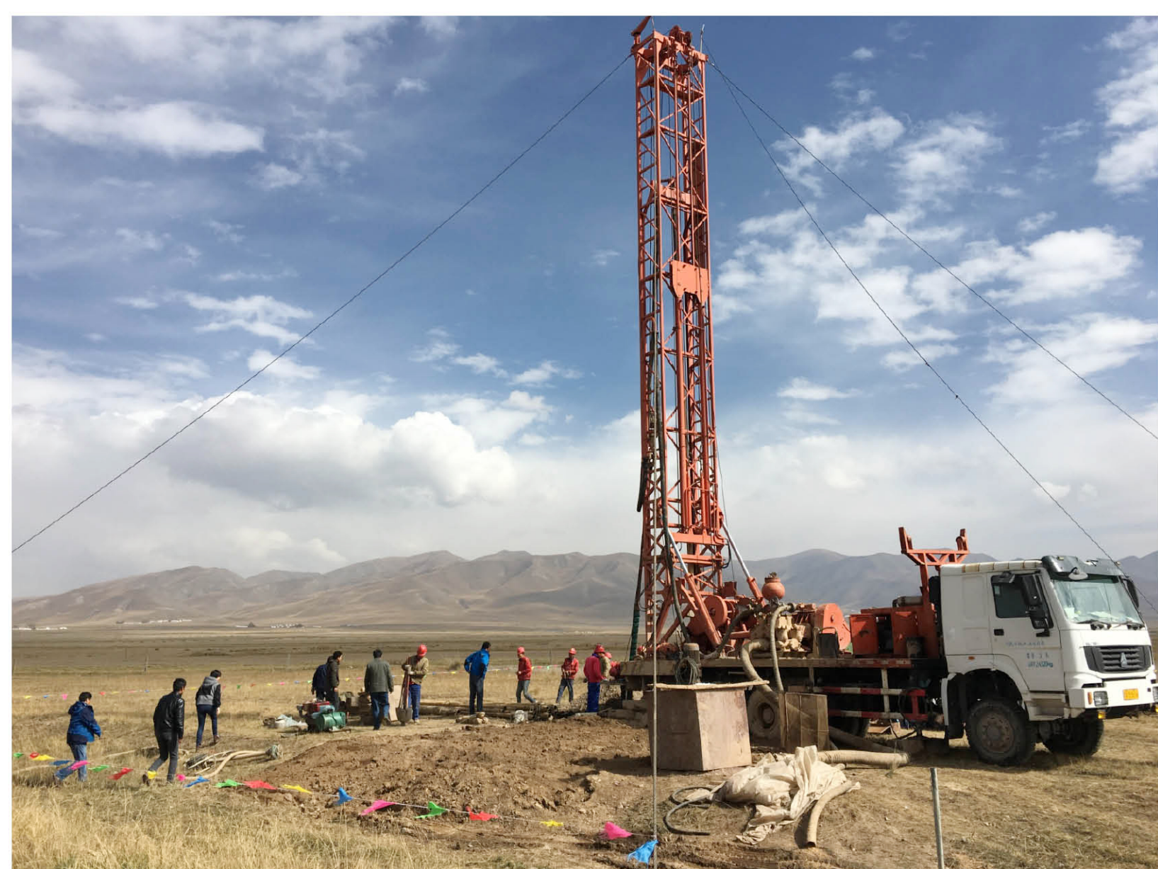
监测井建设施工现场
