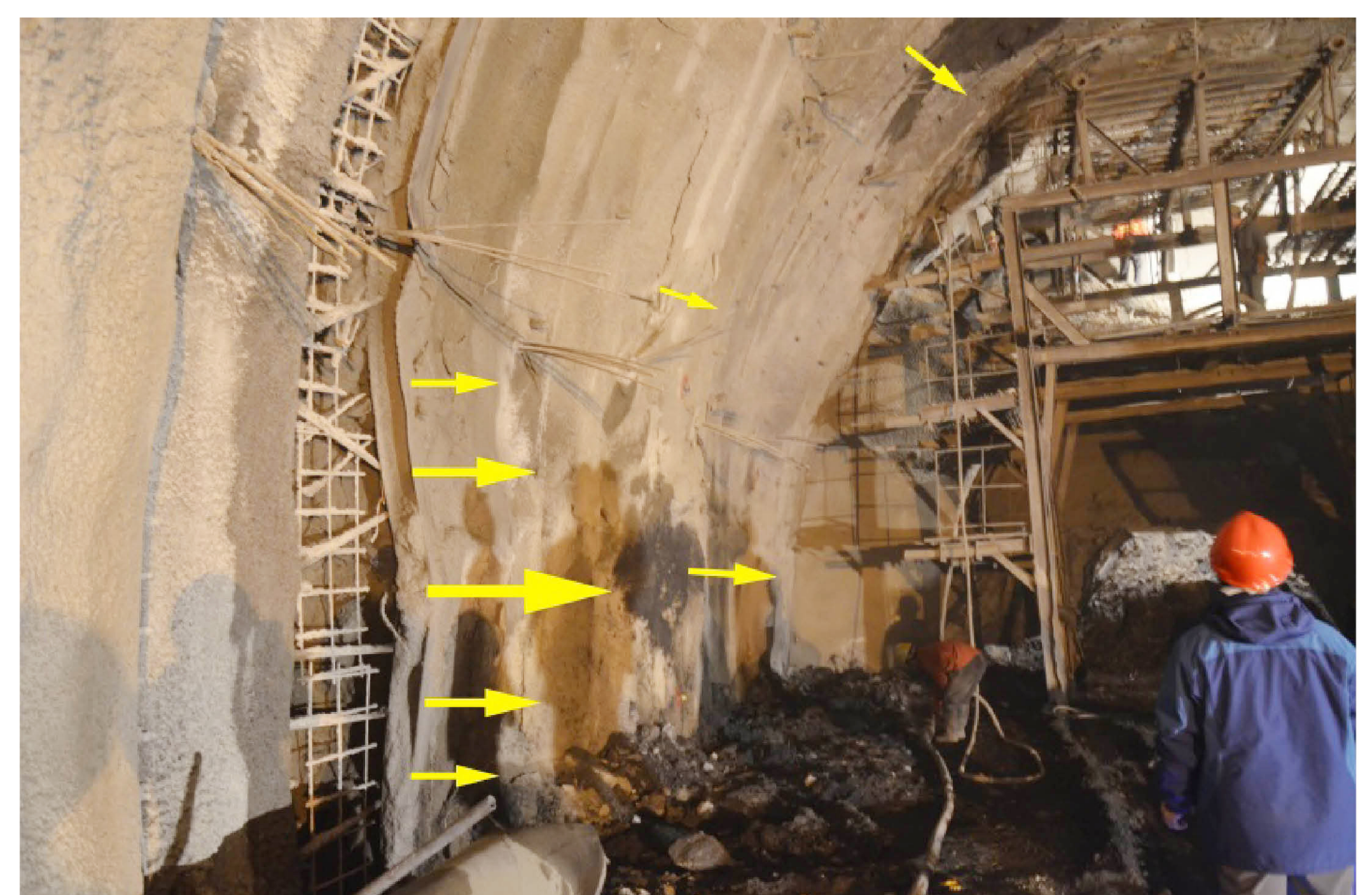
支撑解决兰渝铁路木寨岭隧道大变形重大 工程地质问题。
