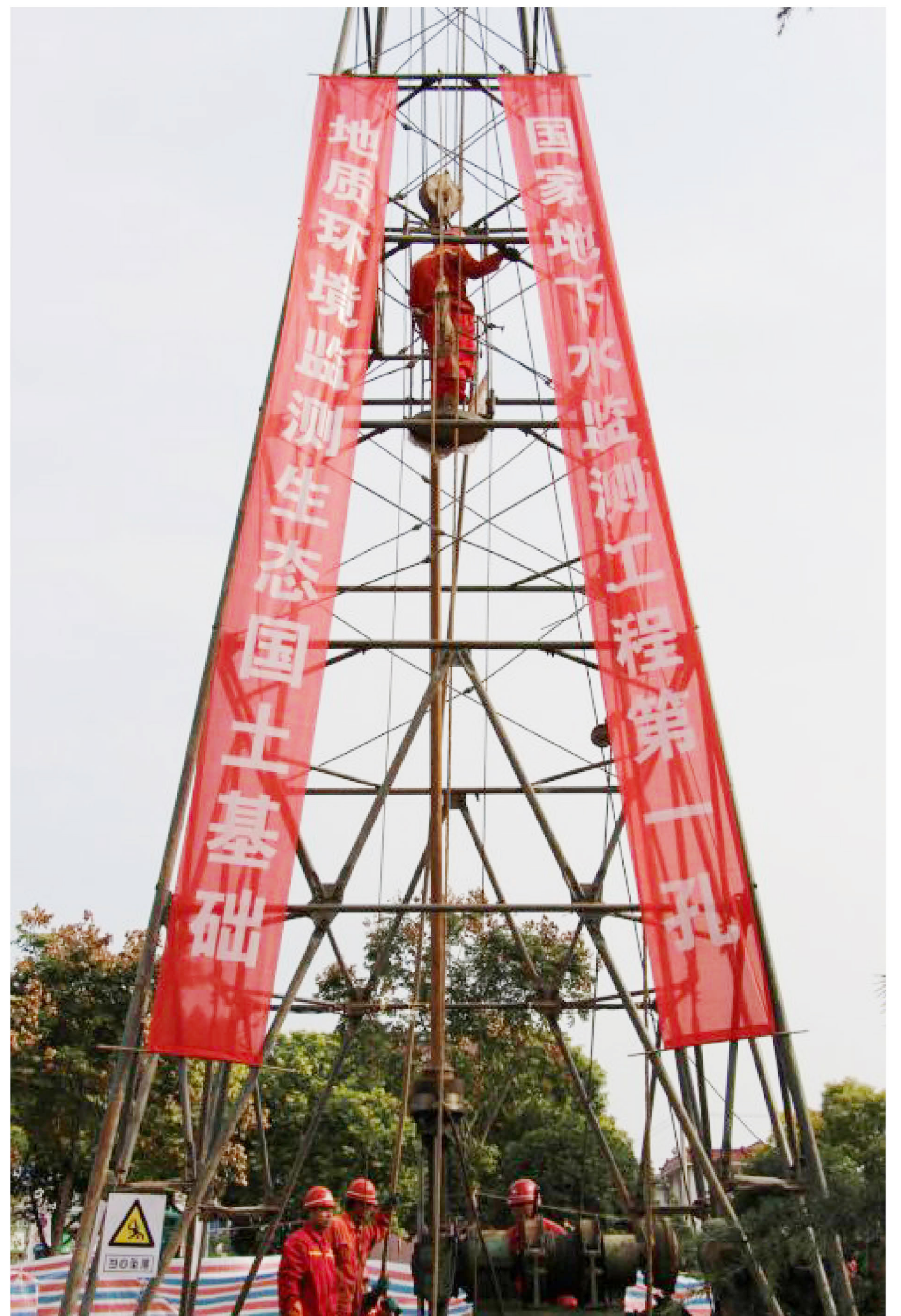
国家地下水监测工程第一口井开工
