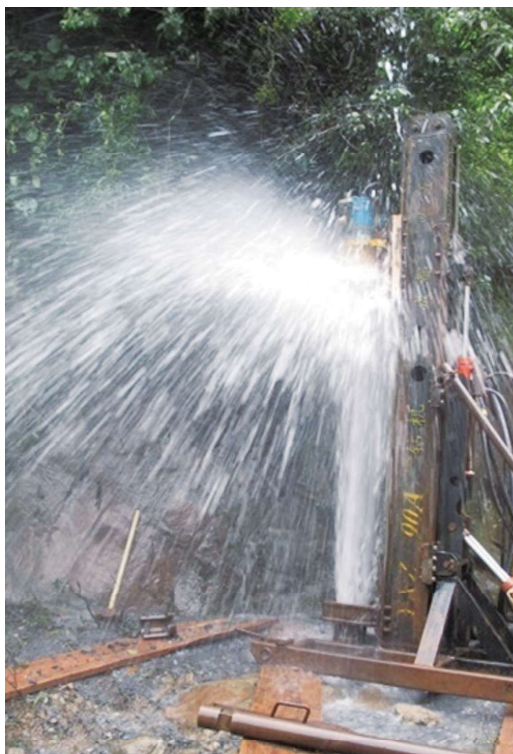
探采结合井出水
