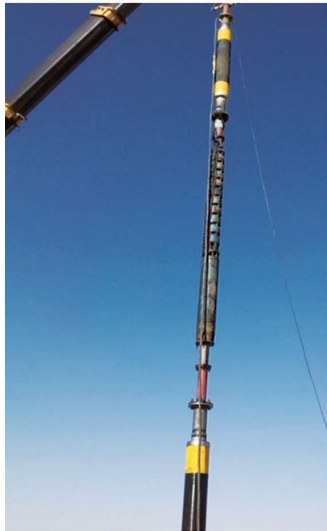
设备安装实景图
