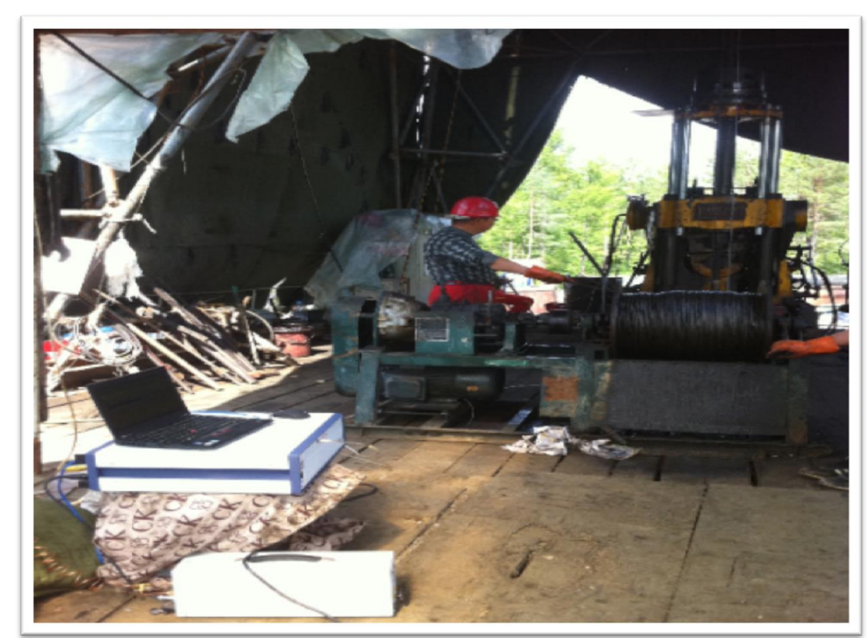
钻井现场检测井口游离气
