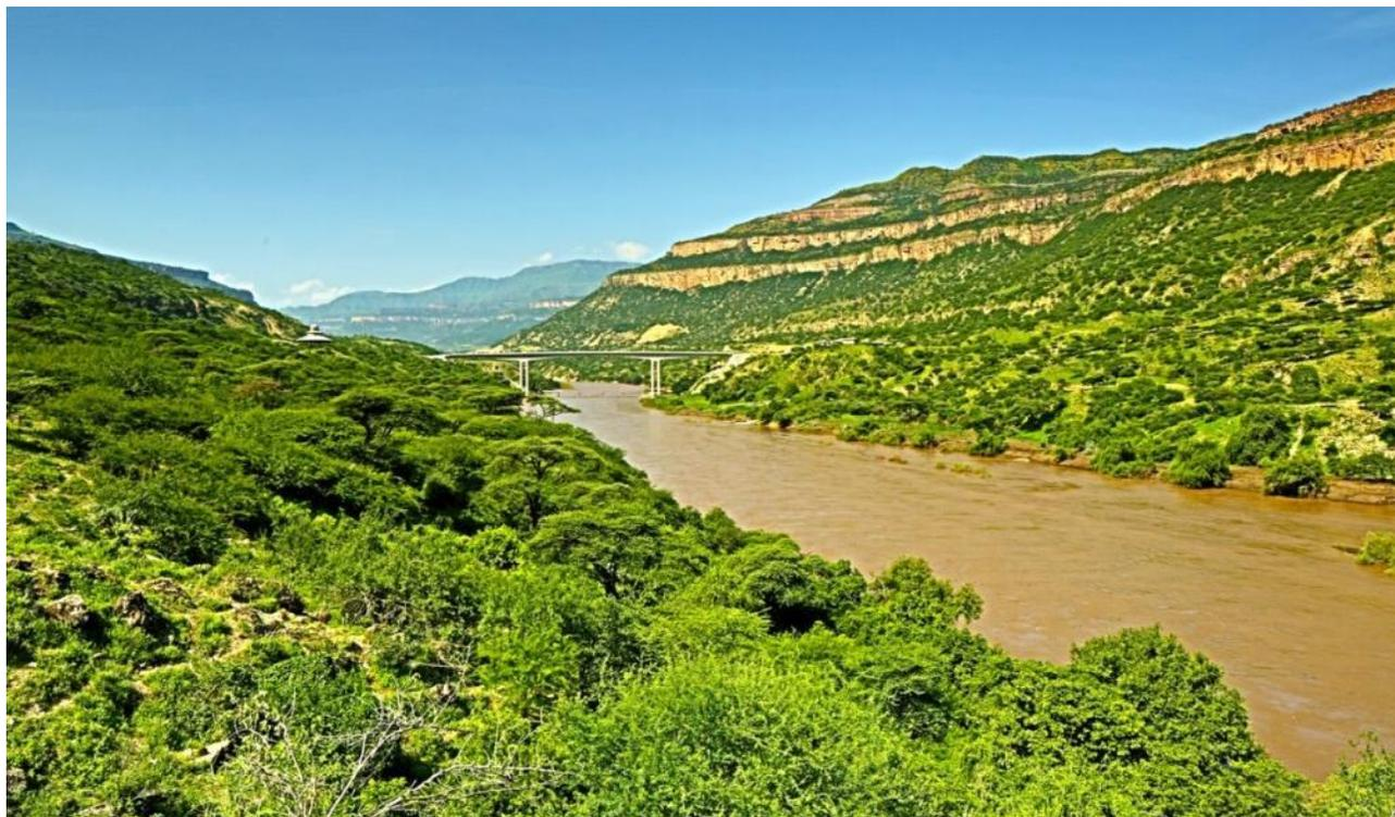
尼罗河大桥为埃塞俄比亚第一座预应力混凝土连续钢构桥，也是当前埃塞境内单孔跨度最大的公路桥梁。项目位于埃塞俄比亚阿姆哈拉州，为中地海外建设集团负责实施的KOMBOLCHA—GUNDEWEIN公路第二合同中的重要分项工程。桥梁横跨蓝尼罗河，结构形式为76m+130m+76m三跨预应力混凝土连续钢构桥。桥梁全长为294.2m宽度1.3m+8.0m+1.3m。该大桥的建成使得两岸隔绝状态彻底成为历史，有效促进了地区间交往，方便了当地人民的生活。
