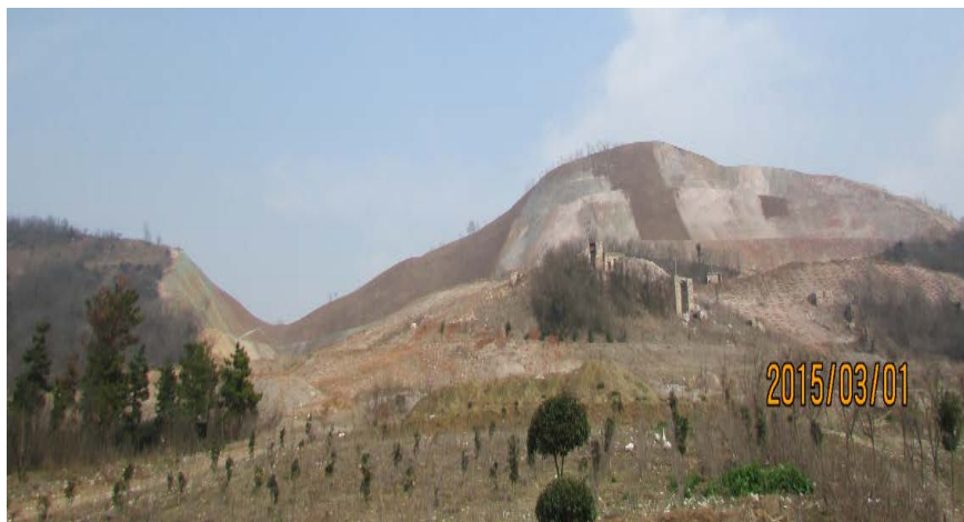
环巢湖地区矿山环境治理已完成 的一期治理工程局部
