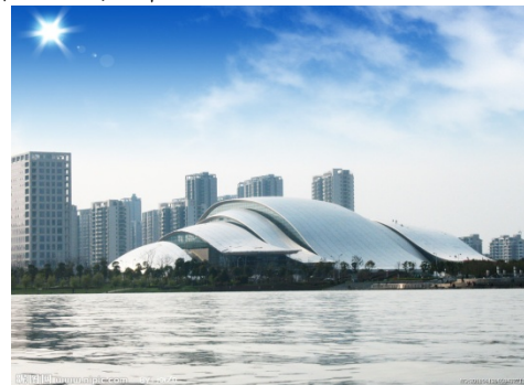
合肥大剧院采用地表水源型地源热泵系统
