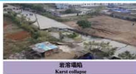
岩溶塌陷 Karst collapse
