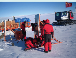
安装地震台站
